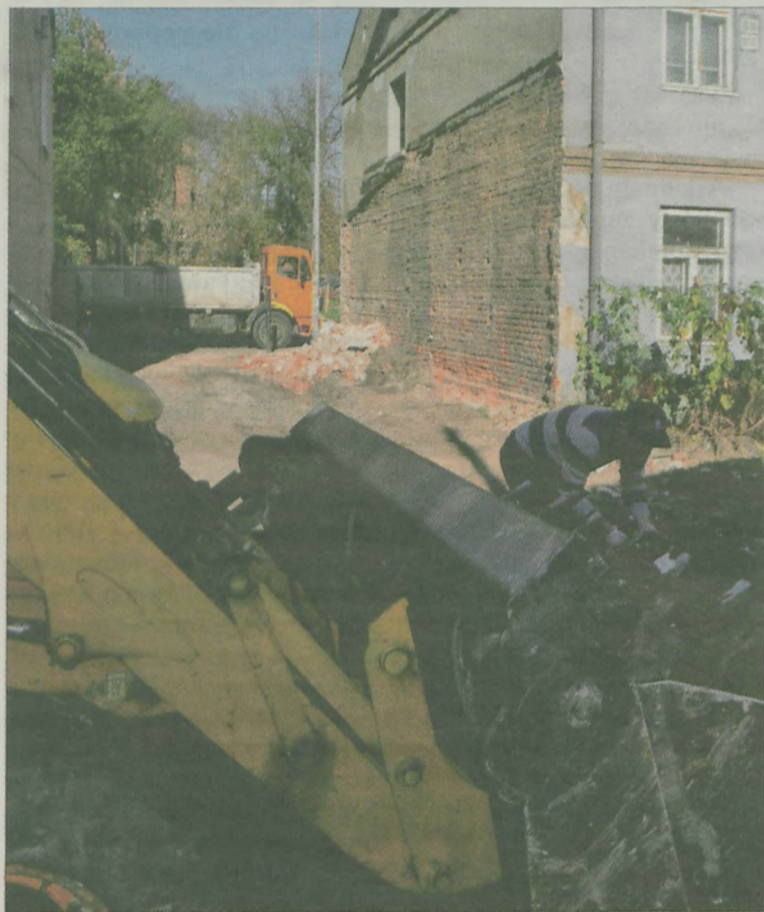
Ekipe remontowej udało się w końcu rozebrać pomieszczenia. Zatrzymali się przy „9”.
