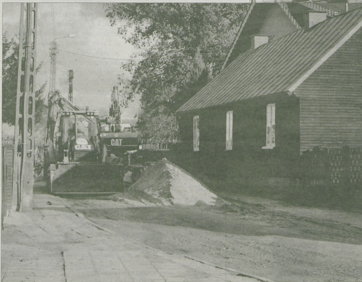
Na ulicy ks. L. Sperczyńskiego przy wjeździe na Plac Zamysłów trwały intensywne prace nad układaniem rur kanalizacji sanitarnej.
