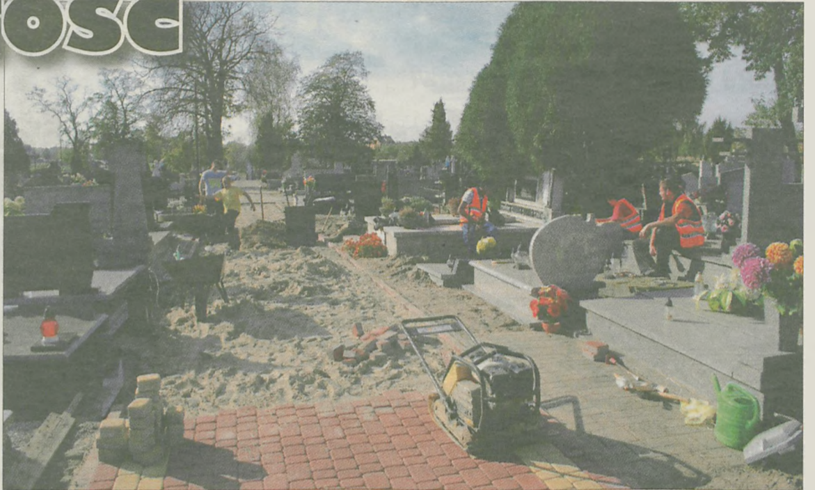
Trwają prace przy budowie cmentarnego chodnika.
