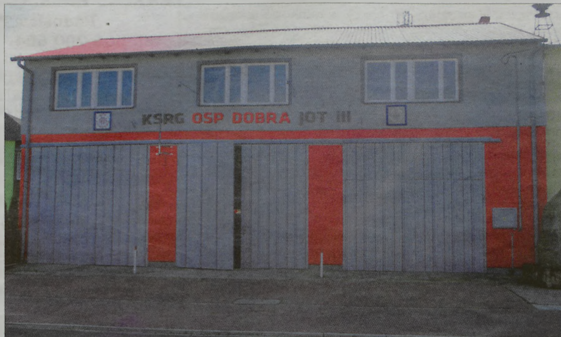
Nowa elewacja dobrskiej remizy.
