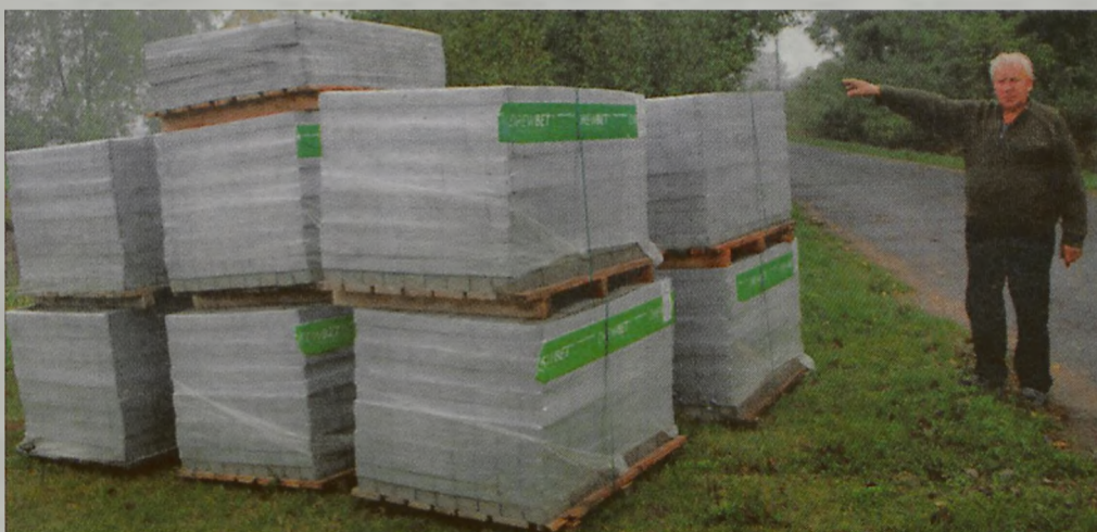
Radny Jerzy Tybura pokazuje nam materiały na budowę chodnika w Lekaszynie.
