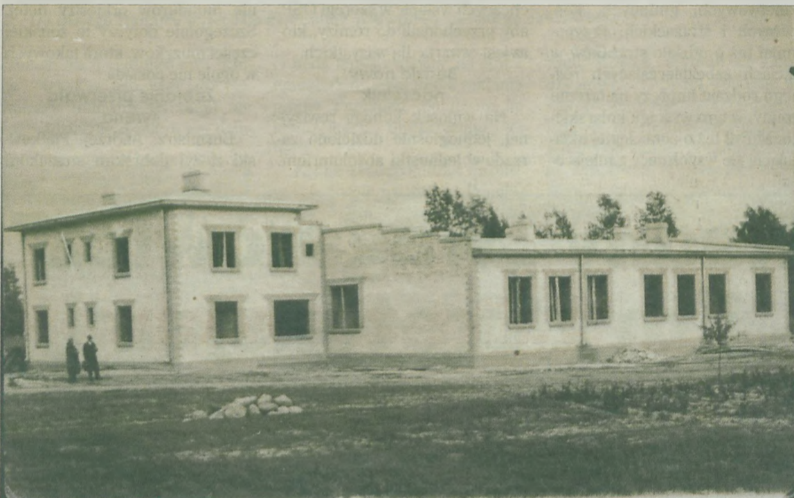
Archiwalne zdjęcie z budowy szkoły w Dąbrowicy w latach trzydziestych XX wieku.
