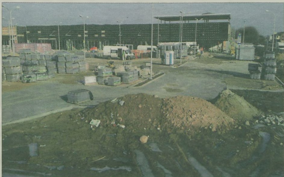
Pogoda sprzyja pracom budowlanym, które prowadzone są w szybkim tempie.
