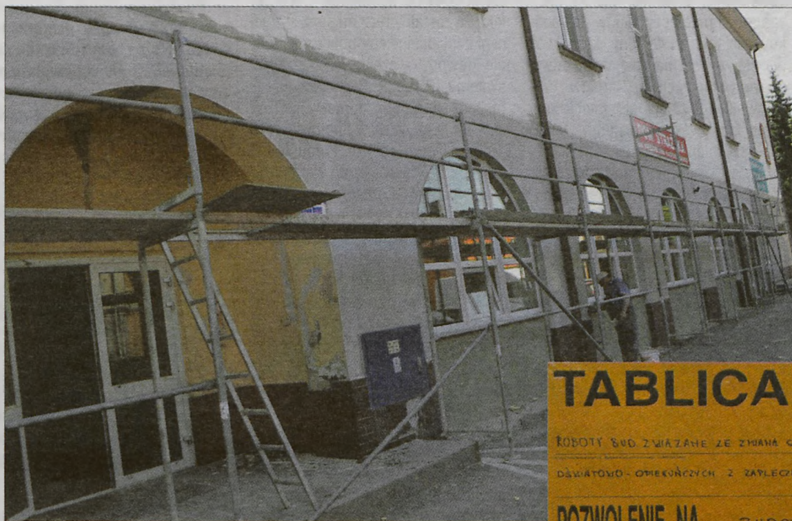
Remont budynku strażnicy dobiega już końca.
