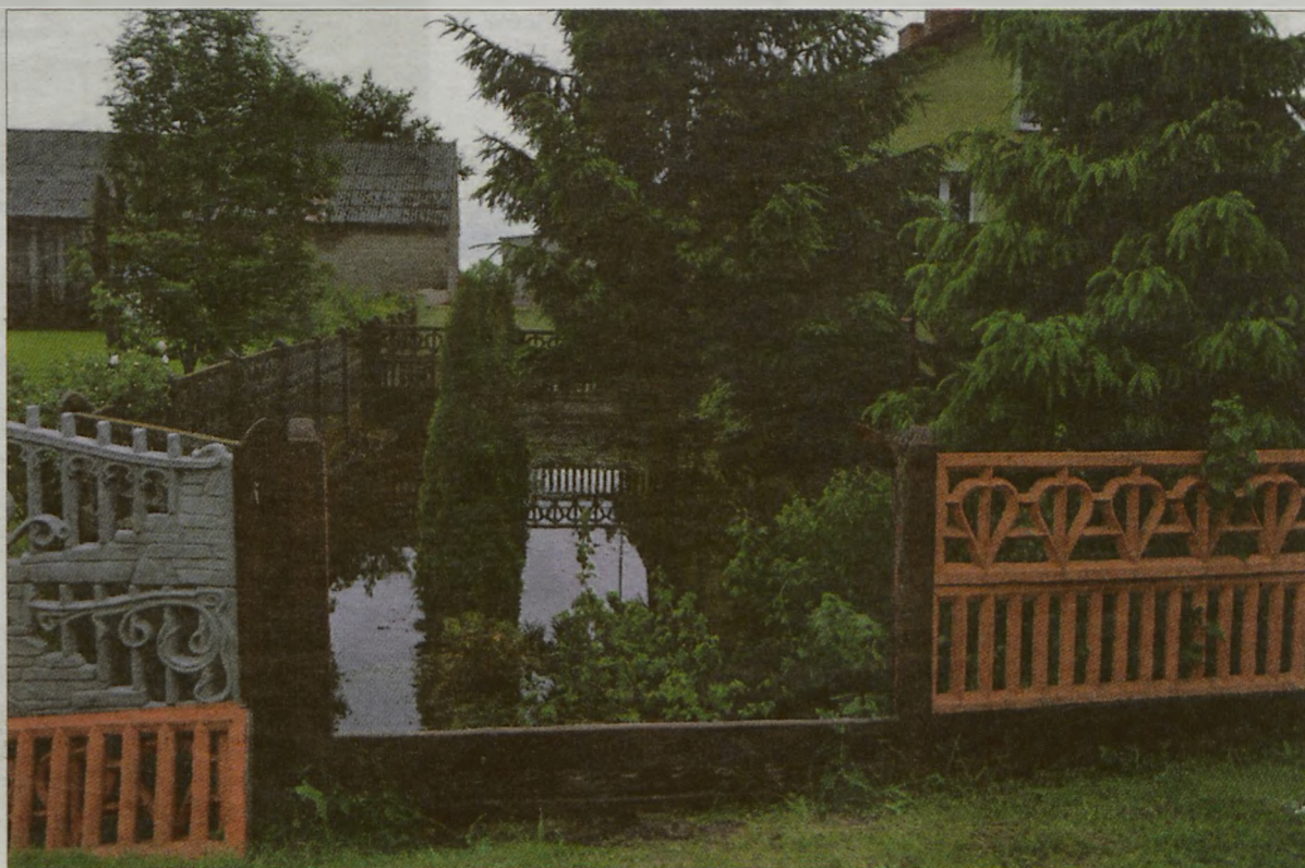
Woda z działki powinna spływać rurą poprowadzoną pod drogą, niestety przepływ jest zablokowany.
