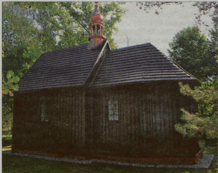
Kościółek na Puszczy nie było remontowany dwieście lat. Teraz ma nową elewację, dach i odnowioną wieżyczkę.
