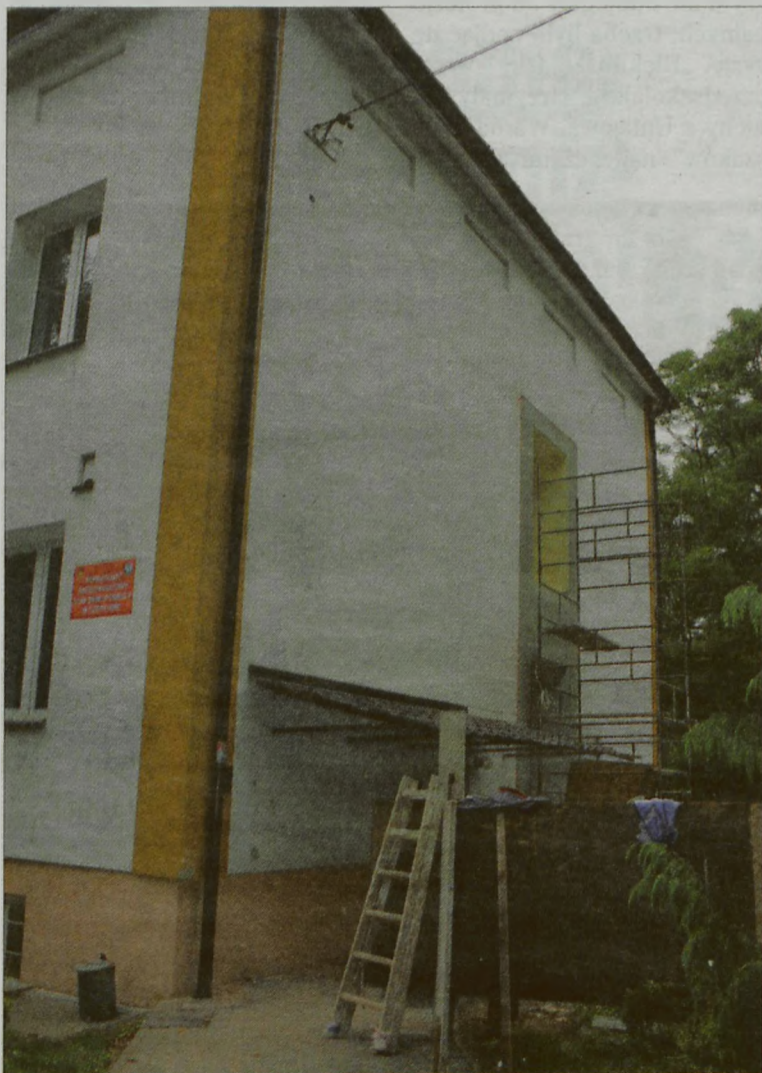
W PŚDS przygotowywane jest miejsce na windę.
