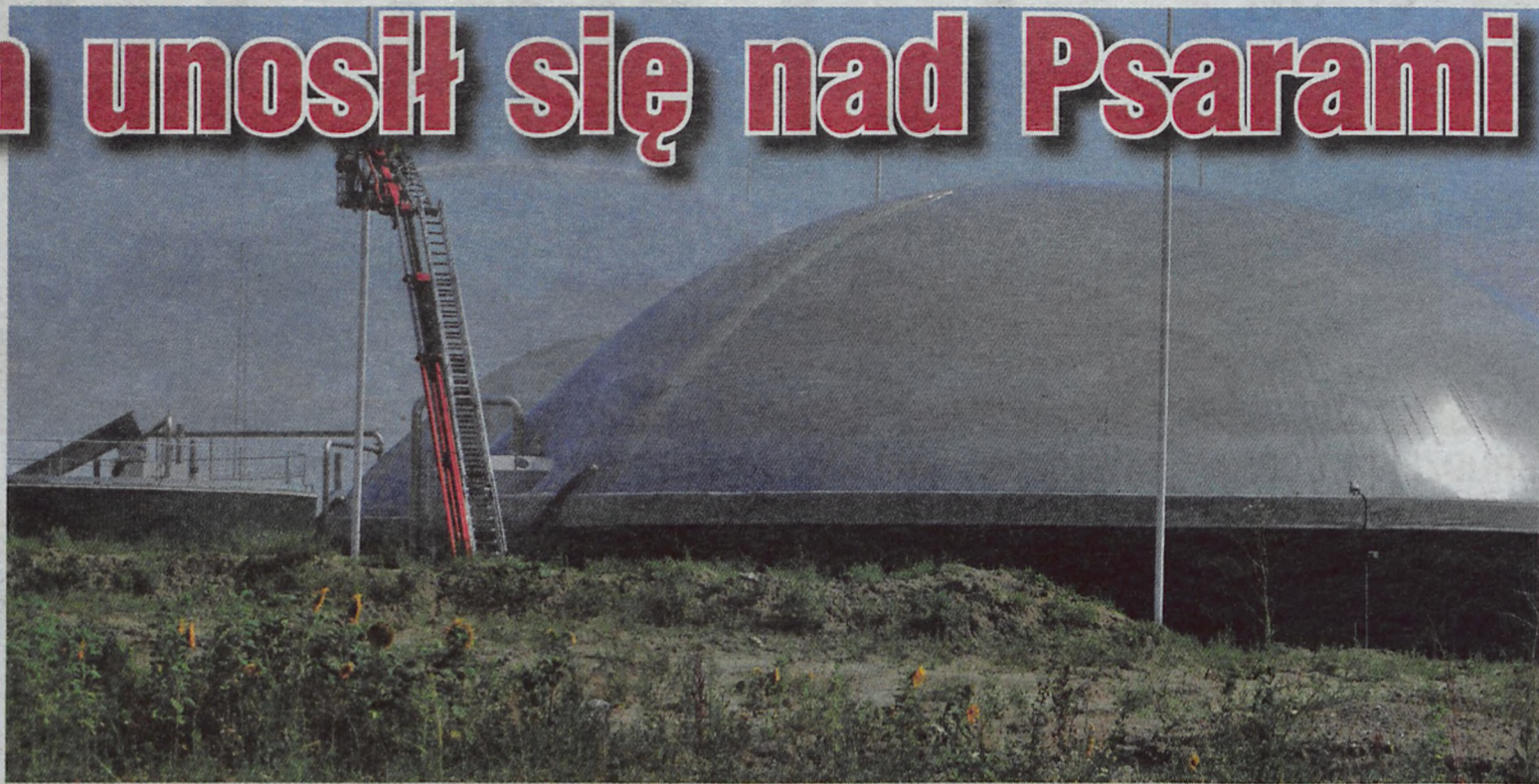
Ćwiczenia strażaków polegały na zabezpieczeniu wycieku metanu z biogazowni w Psarach.
