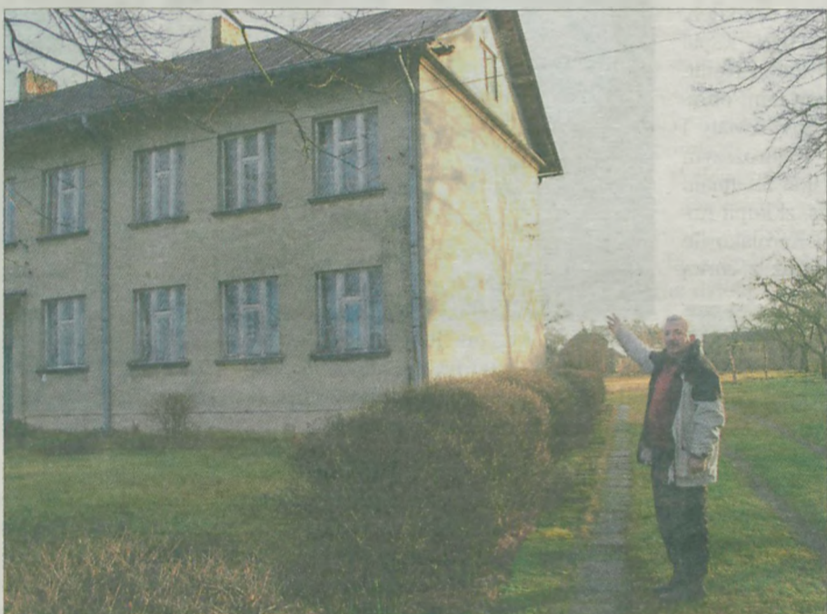
Sołtys Paweł Wszędybył pokazuje budynek niszczonej szkoły.
