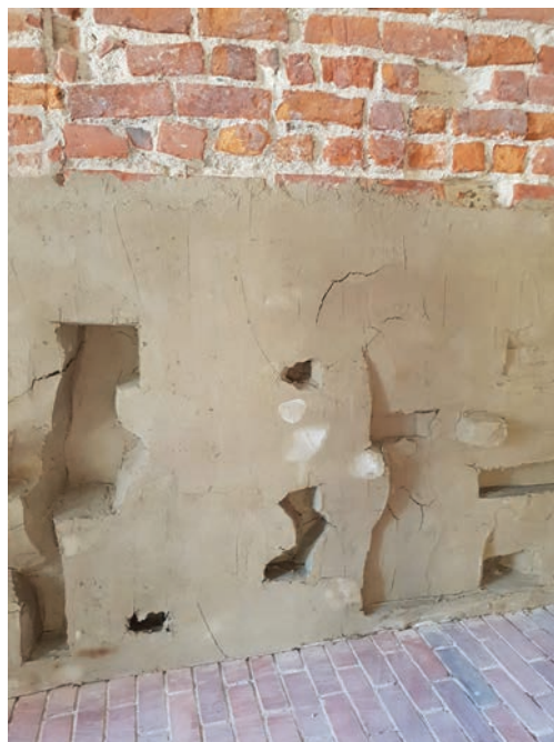
Il. 7, 8. Kompresy odsalające nałożone na ściany przyziemiu zamku; widoczne białe wykwity wyekstrahowanej z muru soli. Fot. Katarzyna Wypych
