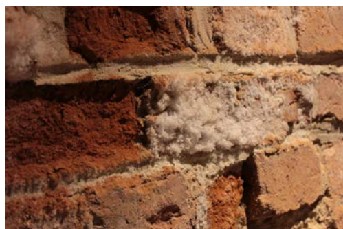
Il 2. Ściana w pomieszczeniu nr 13, widoczny poziom degradacji ceglanego muru. Fot. Katarzyna Wypych
