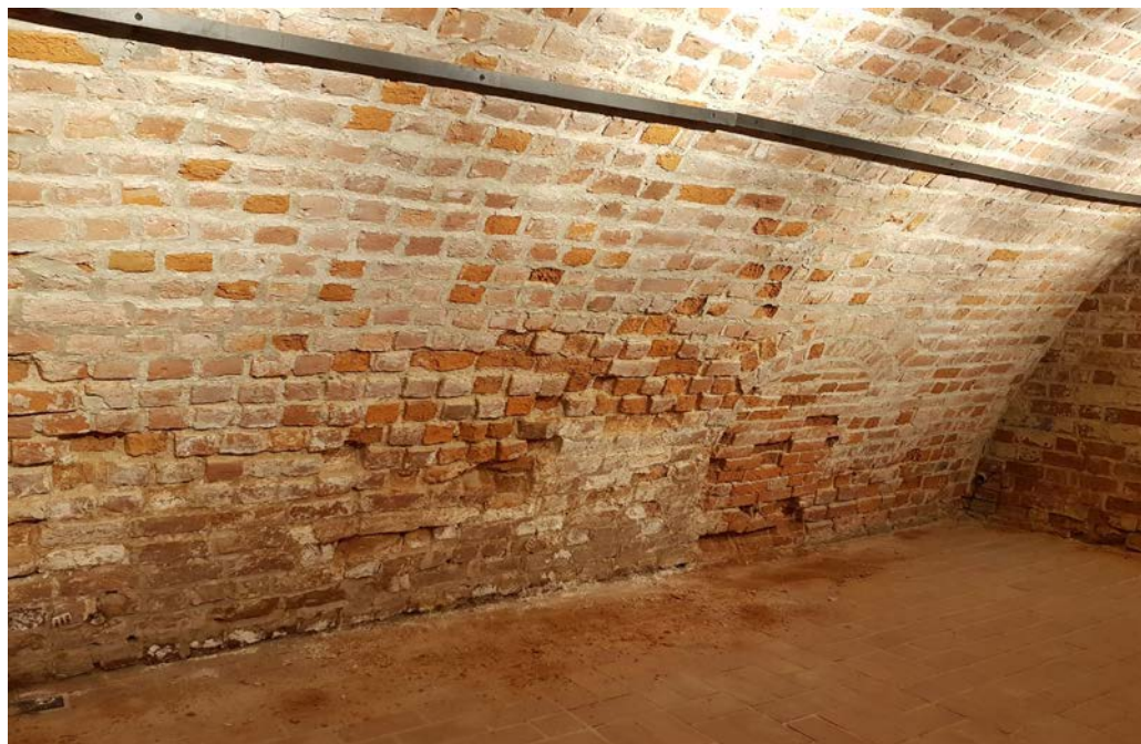
Il 2. Ściana w pomieszczeniu nr 13, widoczny poziom degradacji ceglanego muru. Fot. Katarzyna Wypych
