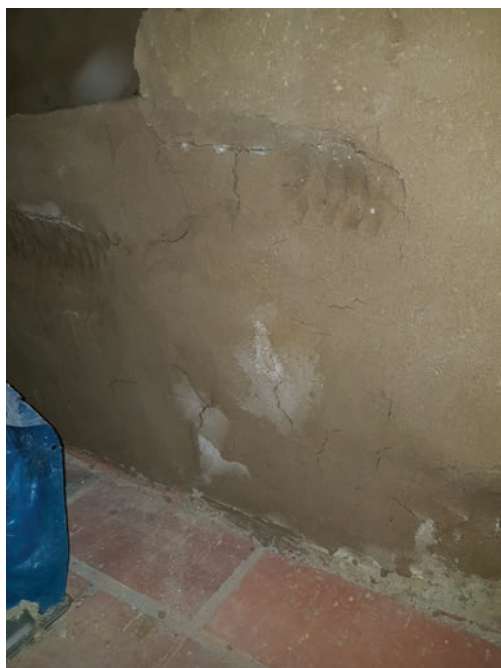
Il. 7, 8. Kompresy odsalające nałożone na ściany przyziemiu zamku; widoczne białe wykwity wyekstrahowanej z muru soli. Fot. Katarzyna Wypych
