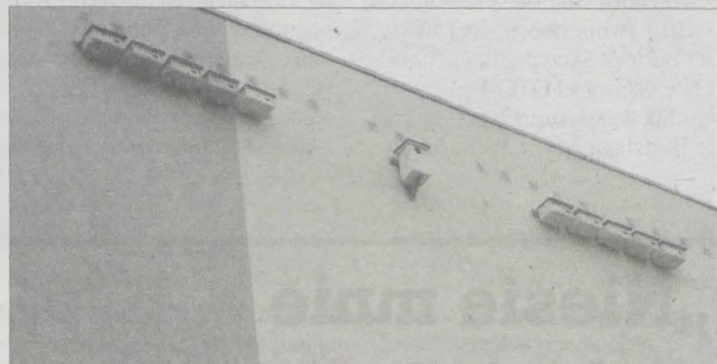
Przykładowy sposób kompensacji siedlisk kawki i jerzyka, wykonany za pomocą trocinobetonowych budek. Jerzyki żyją w koloniach, budki zaleca się więc wieszac po kilka obok siebie
