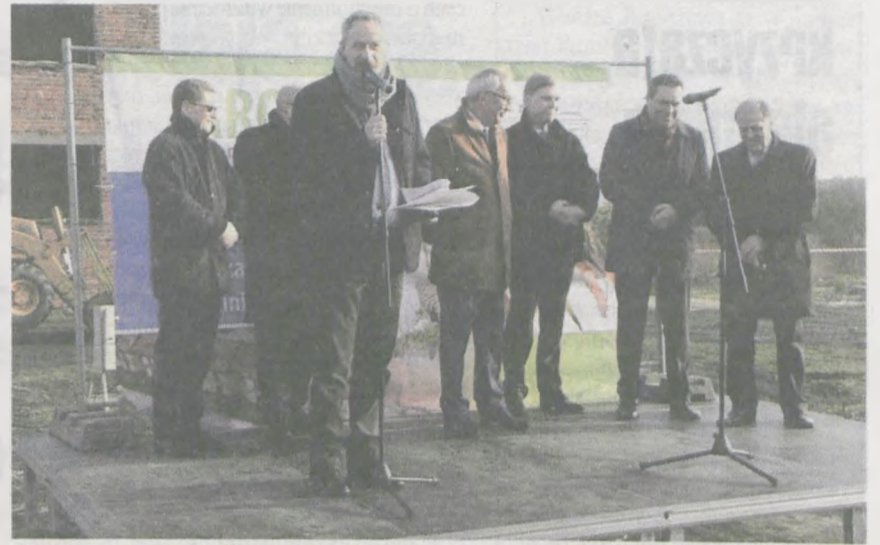
- Najpierw trzeba coś usunąć, żeby na tym miejscu coś powstało - powiedział sekretarz gminy Michał Fijałkowski podczas przekazania placu budowy. Dał znak i koparka oderwała fragment budynku na Leszczycach, który zostanie zburzony.
