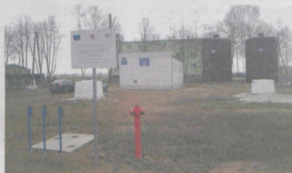
W ramach PROW 2007-2013 w województwie wielkopolskim wybudowano łącznie około 2220 km sieci wodociągowej i kanalizacyjnych, 290 oczyszczalni ścieków oraz 2785 przydomowych oczyszczalni ścieków. Nowy program wspiera dalsze inwestycje gmin w gospodarkę wodno-ściekową
