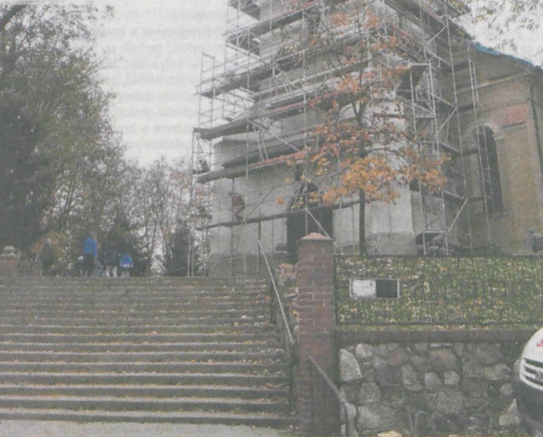
Trwa remont kościoła p.w. Najświętszej Maryi Panny w Górze
