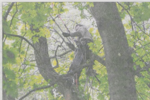
Niektóre prace są wykonywane metodą alpinistyczną
