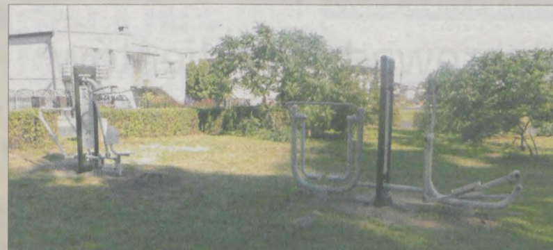
Blisko 25 tys. zł wydano na budowę siłowni przy ul. Orzeszkowej
