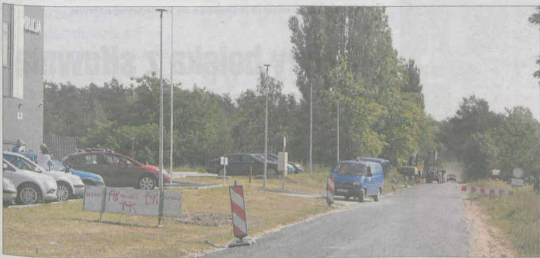
Wykonawcą przebudowy drogi Jarocin - Wola Książęca jest firma Skanska
