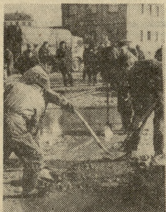
Na zdjęciu — ekipa Wodociągów przy pracy na miejscu awarii.
