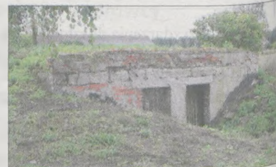
Ogień został zaproszony w piwniczce przy świetlicy wiejskiej. Oprócz tego w Stramnicach płonęły baloty oraz stóg
