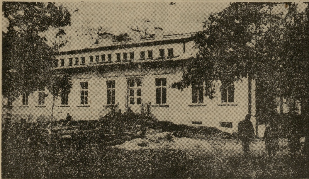
Dom Socjalny w przedsiębiorstwie PGR Działyn, który pomieści: stołówkę, bibliotekę, klub, gabinety lekarskie i dentystyczny oraz mieszkanie dla kierownika Ośrodka.
