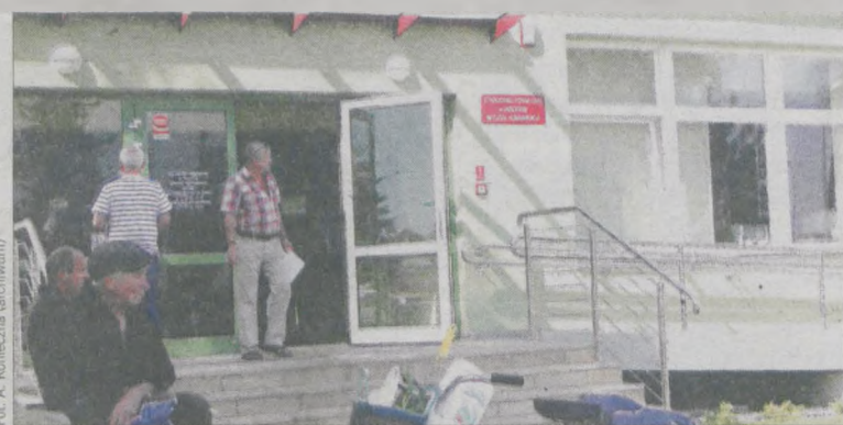
(ann) Referat komunikacji od 2011 r. mieści się w budynku przy ul. Zaciszej
