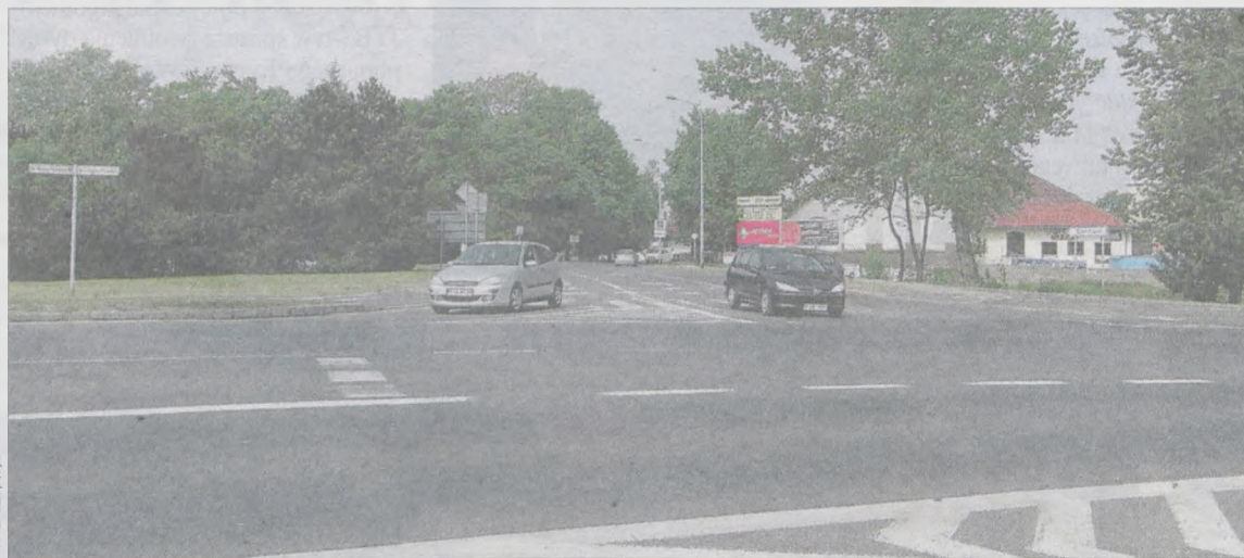
Budowa nowego łącznika, który będzie przebiegał od ul. Wrocławskiej przez Bema i Śródmiejską do nowej obwodnicy zakłada powstanie ronda przy stacji paliw Lukoil
