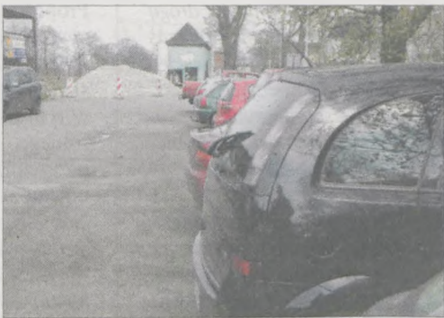
Część mieszkańców w czasie budowy parkingu zostawia samochody pod zakazem
