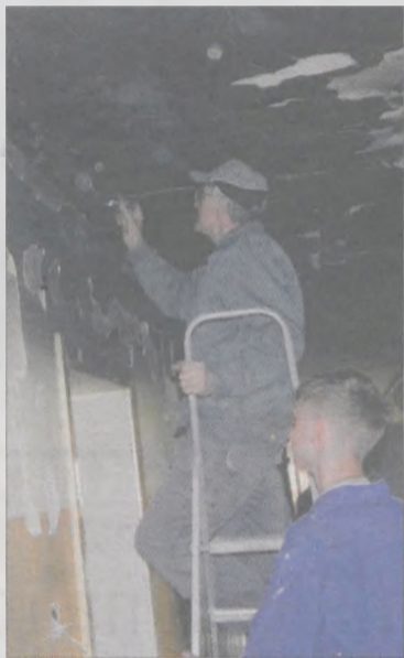
Pracownicy JTBS sprawdzali instalację elektryczną
