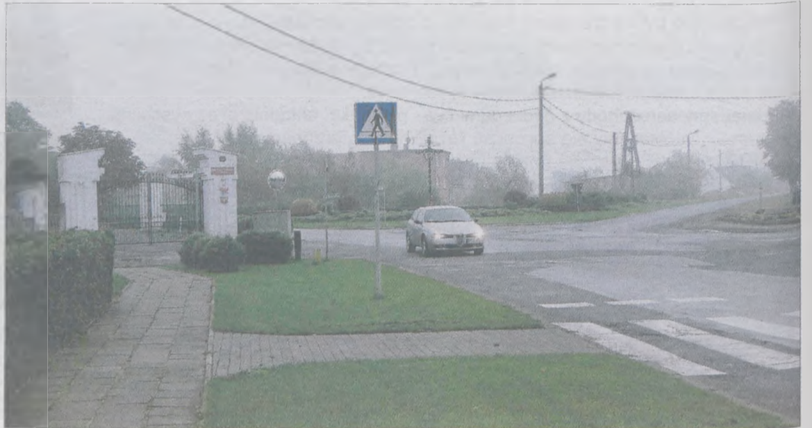
W ramach przebudowy na skrzyżowaniu w Zakrzewie powstanie rondo, a wzdłuż całego 3-kilometrowego odcinka zmodernizowanej drogi ścieżka rowerowa
