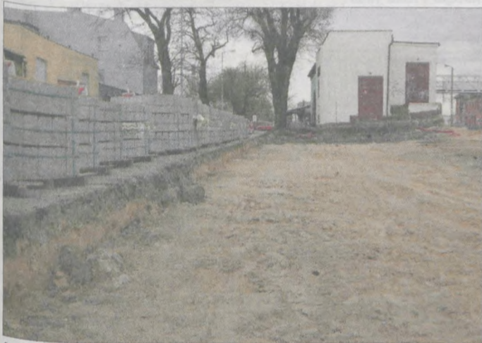
Jeszcze trzy tygodnie ma trwać budowa nowego parkingu w Jarocinie
