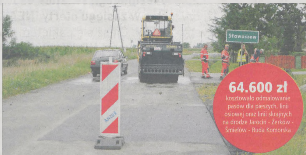
Droga Kotlin - Sławoszew - Sucha była modernizowana w 2011 r.
