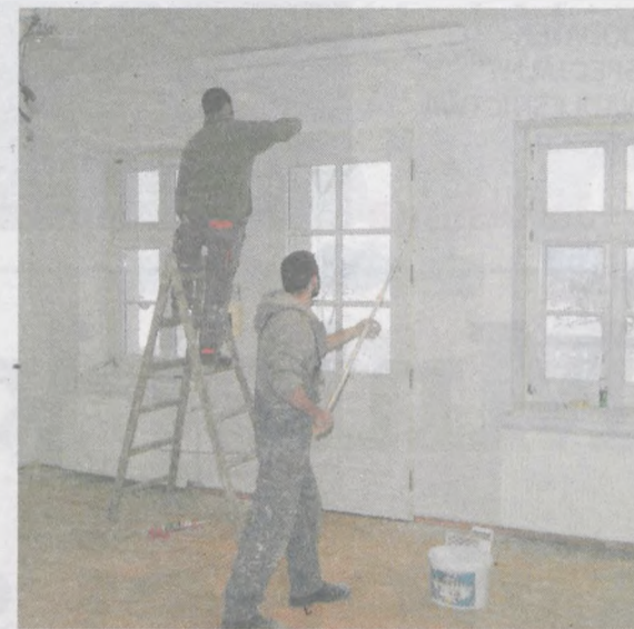
Sala multimedialna, I piętro - malowanie
