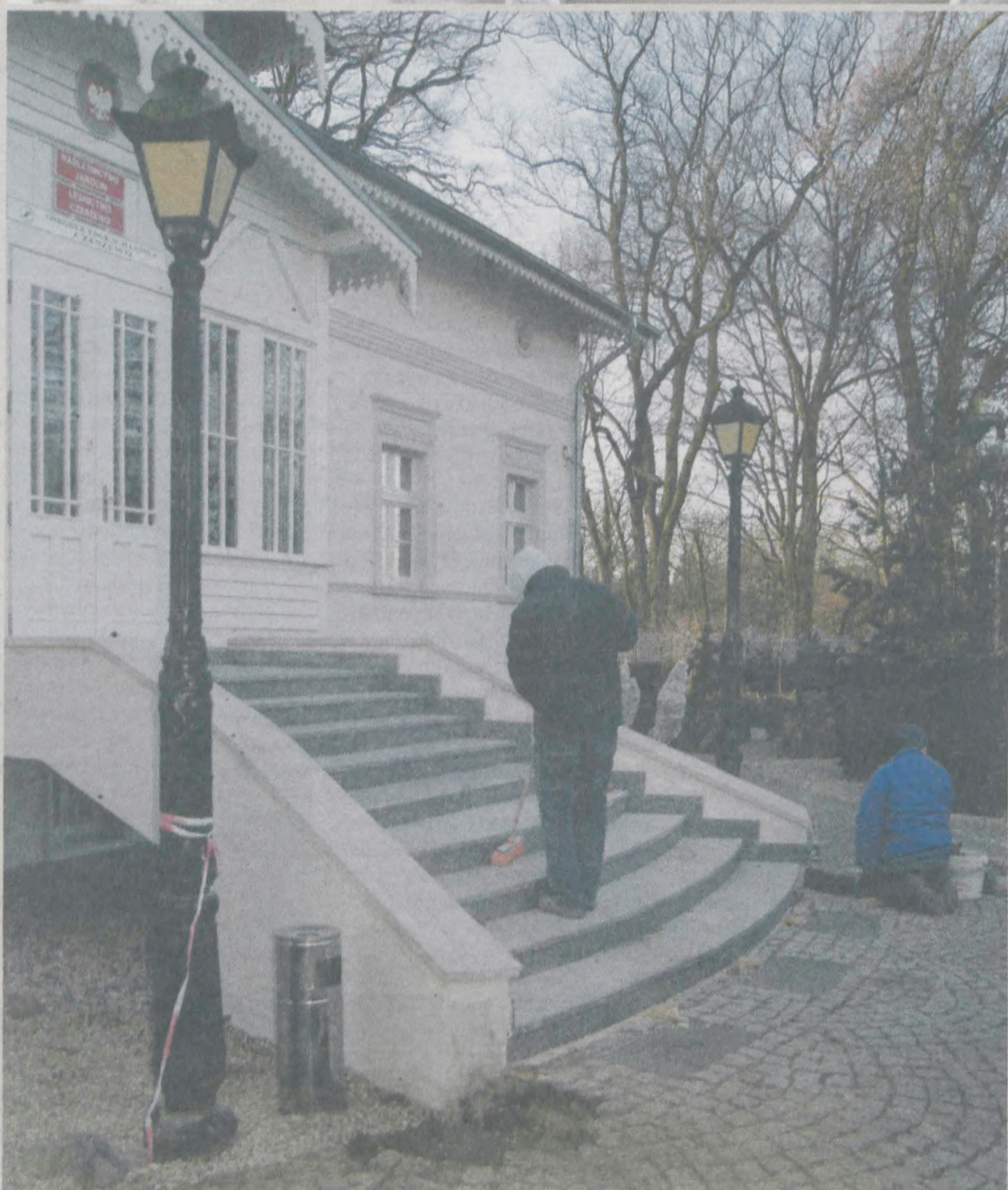
Prace na schodach frontowych: usunięcie gresu, wyrównywanie, montaż poszczególnych elementów
