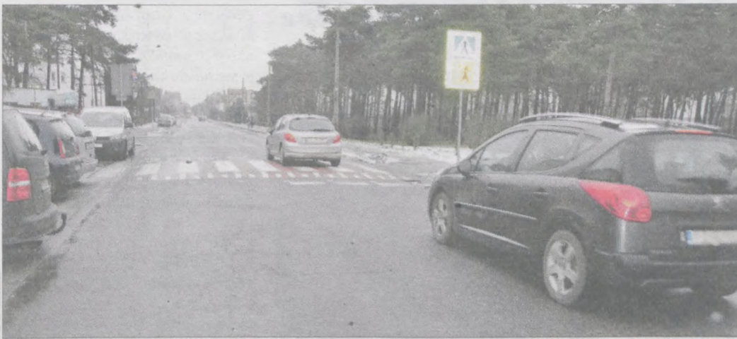
Wyniesione ponad poziom jezdni przejście spełnia swoje zadanie i spowalnia ruch w okolicy szkoły specjalnej
