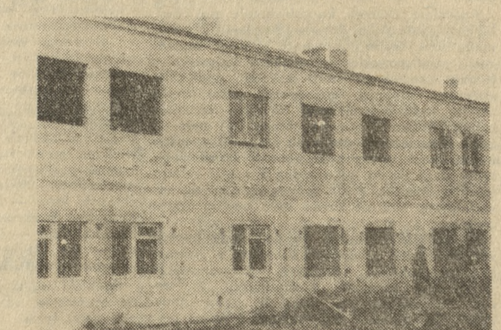
Tak wygląda na budowie kawnickiego Domu OSP.
