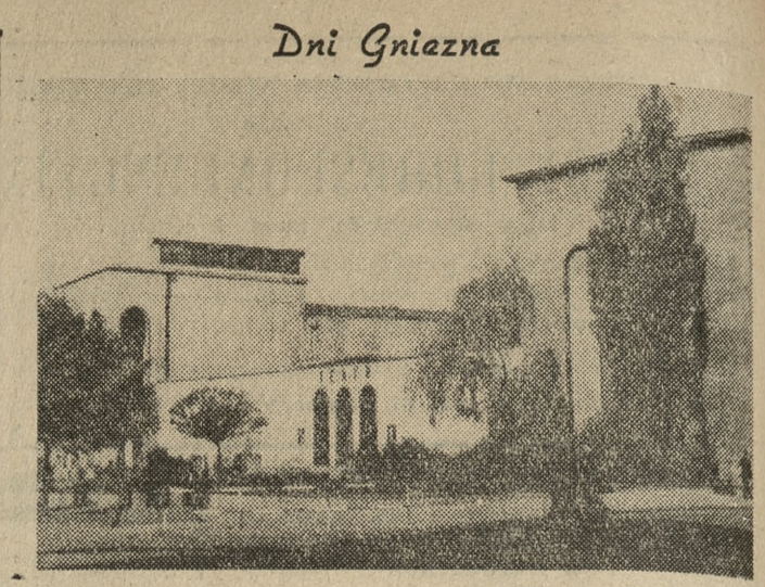
W ostatnich latach budynek teatru im. Aleksandra Fredry został odnowiony i wyremontowany, zwłaszcza unowocześniono scenę i jej zaplecze. Fot. — Janusz Chłasta
