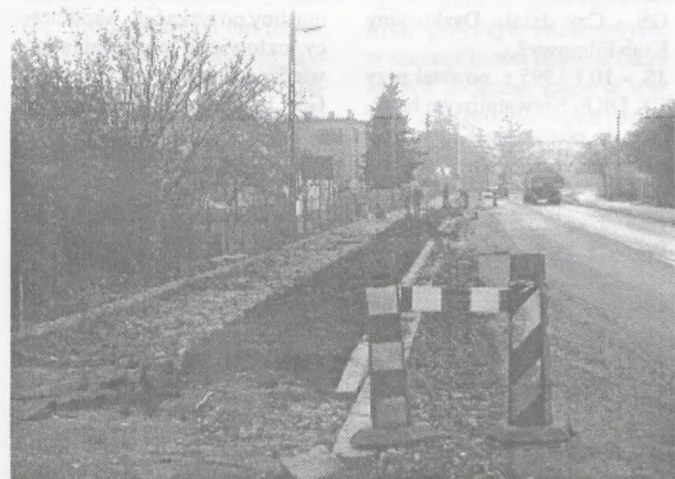
Trwa remont ulicy 3-go Maja (fot J. Krzeminski)
