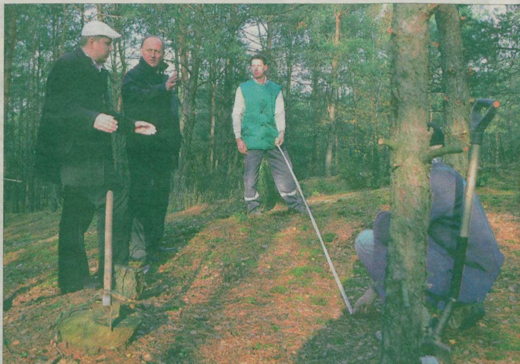
Wymierzanie fundamentu pod lapidarium. Obok wójta Jana Nowaka Marcin Dudek-Lewin.
