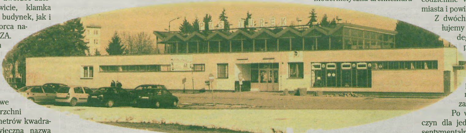
Prawdopodobnie jeszcze tylko kilkanaście dni turkowski dworzec autobusowy pozostanie obecny w pejzażu naszego miasta. Powstały w 1971 obiekt zapewne zniknie zanim zdążą zakwitnąć tegoroczne bzy.
