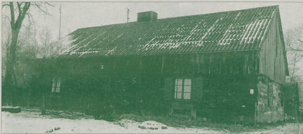
Ten zabytkowy dom rozchodzi się pod wpływem wstrząsów wywoływanych przez przejeżdżające samochody.
