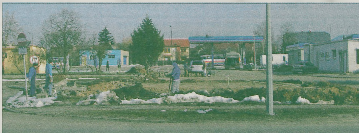
Pracownicy przygotowujący teren pod przyszłe wiaty dla pasażerów PKS-u muszą się spieszyć. Bo do 20 kwietnia teren dworca autobusowego zostanie przejęty przez nowego właściciela, a następnie rozebrany. Na jego zaś miejscu ma powstać kompleks handlowy pod dzwiczną nazwą „Karuzela Turek”.
