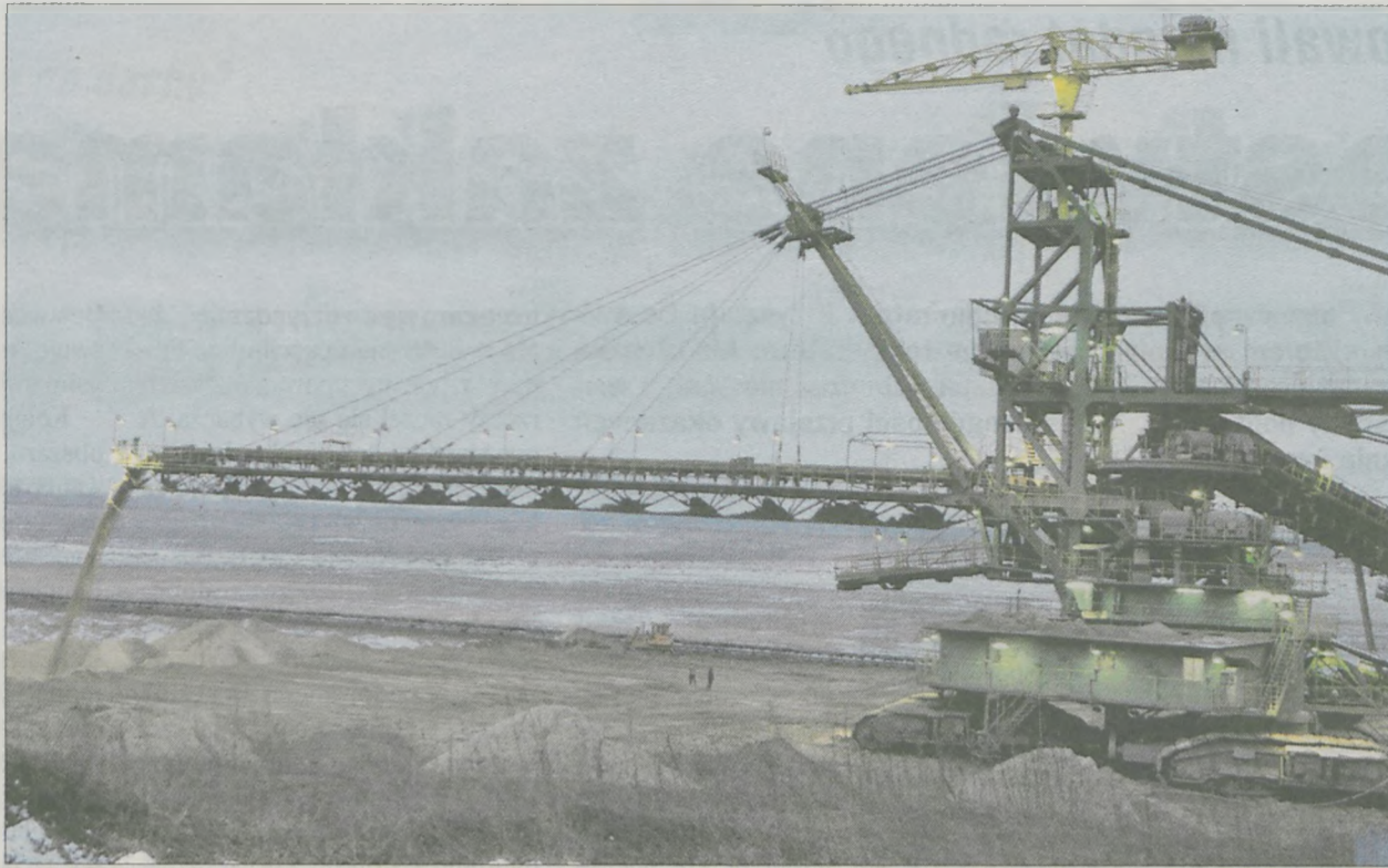
W „Kozminie” na razie odprowadzana jest woda i jak widać zdejmowany piach. Elektrownia potrzebuje węgla z „Sieniawy”.
