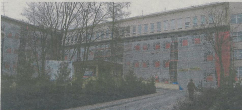
Ocieplenie, elewacja budynków, przebudowa centralnego ogrzewania - to tylko niektóre wykonane w ubiegłym roku prace remontowe w SP ZOZ w Turku.
