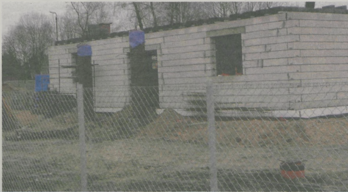
Początek prac budowlanych - styczeń 2012 r.
