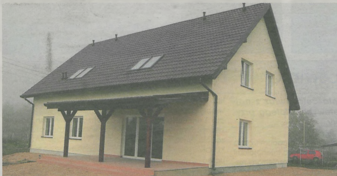
Zakończenie budowy - wrzesień 2012 r.
