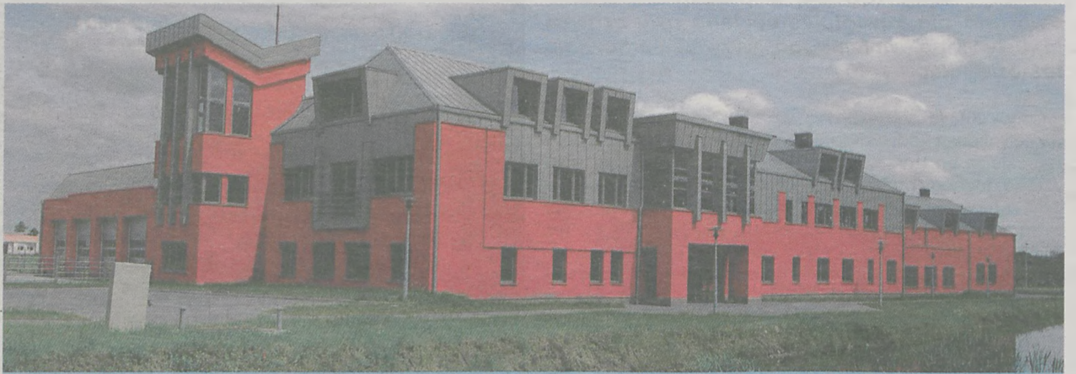
Nowa siedziba Komendy Powiatowej Państwowej Straży Pożarnej przy ul. Działkowej w Turku.
