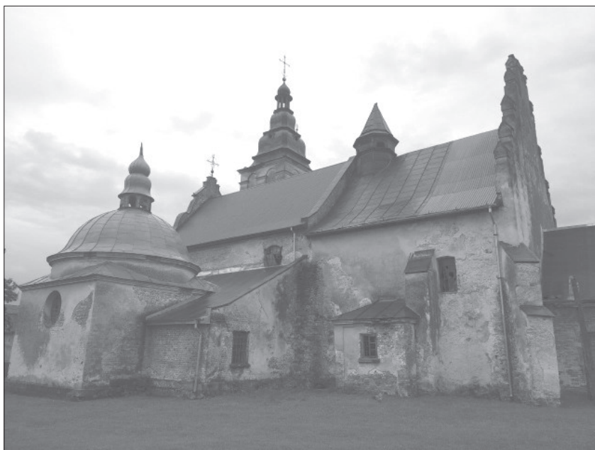
Kościół rzymskokatolicki w Wyżnianach z naprawionym dachem, 2018 r. Fot. Adam Groblewski.
