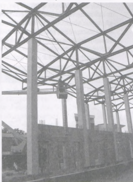
Prace spawalnicze przy konstrukcji stalowej dachu
