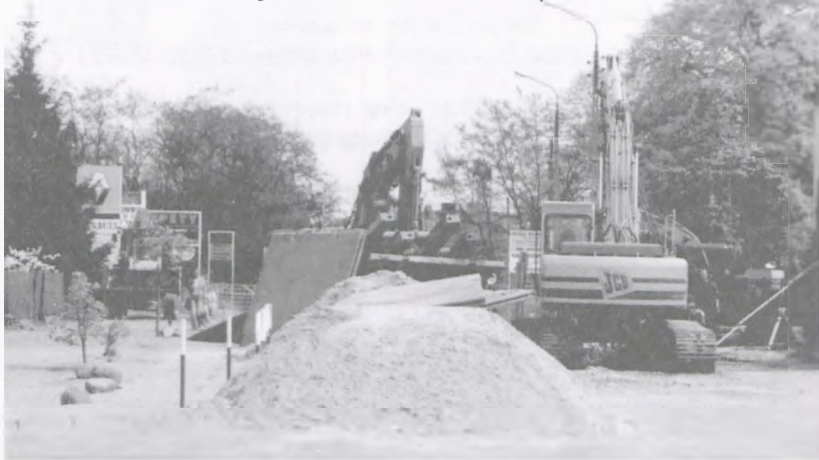
Budowa kanalizacji w ul. Powstańców Wilkp.
