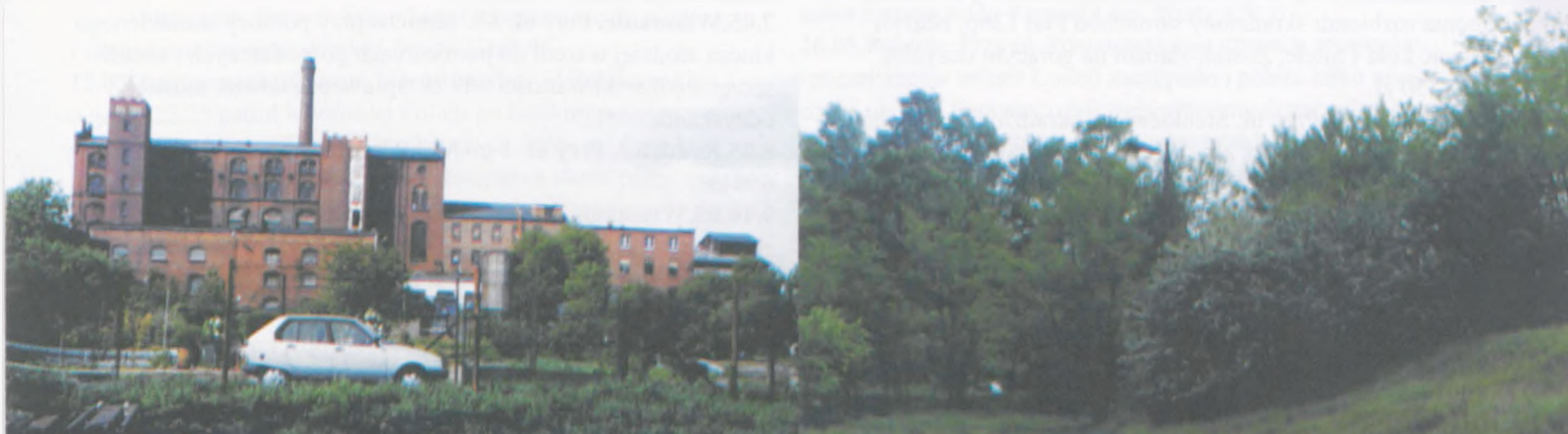
Otoczenie przyszłego cmentarza komunalnego
