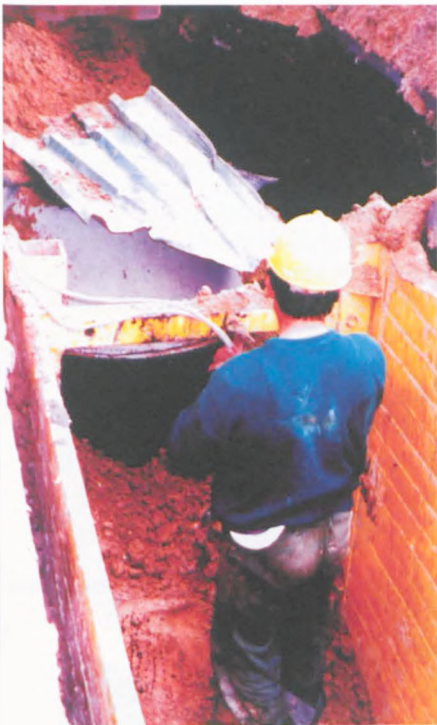
Zakładanie filtrów "igłowych" w wykopie
