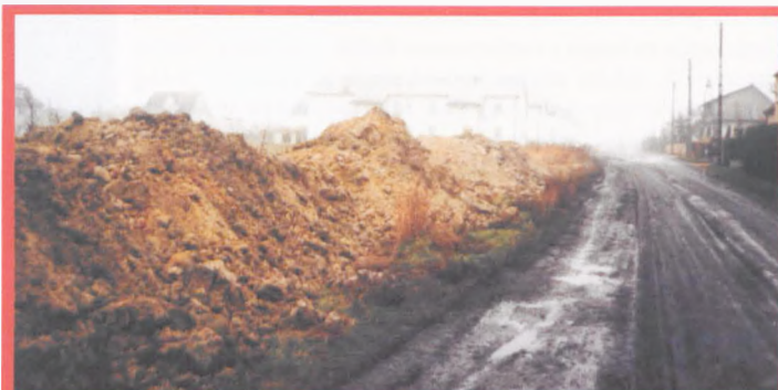
Zwały gliny z wykopów pod kanalizację deszczową z ul. Walki Młodych wysypane na u. Kurowskiego
