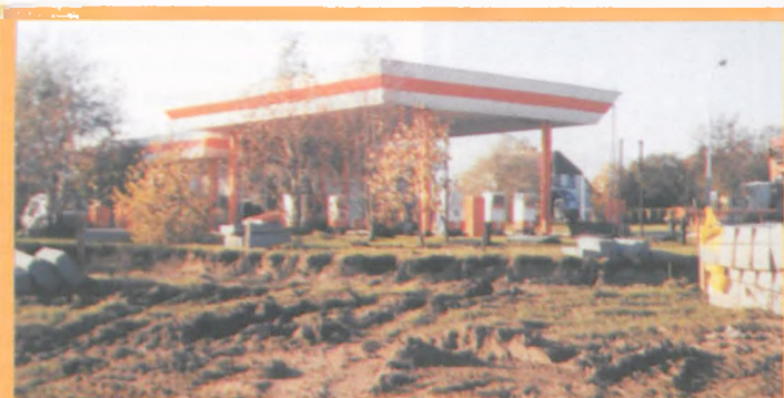
Rozpoczęto przebudowę stacji CPN przy ul. Fabrycznej
