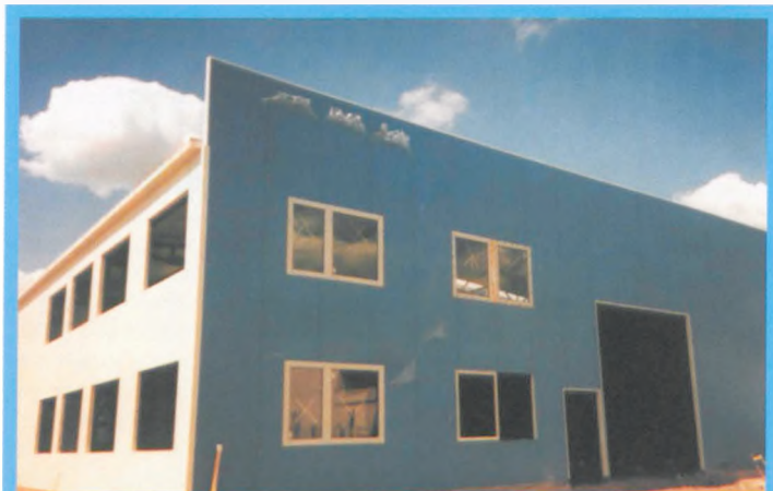
Hurtownia "STAR" przy ul. Sobieskiego (w czasie budowy)
