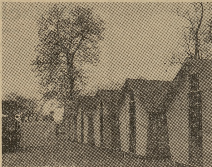
Montaż domków campingowych dla Dziwnowa. CAF — fot. Kondracki
