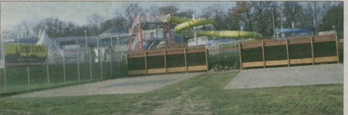
Drewniane tężnie zamiast betonowych ścian. Dobry, czy zły pomysł?
