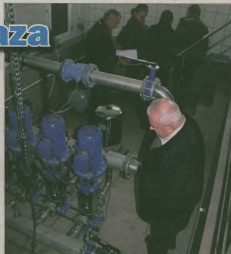
Nowa hydrofornia w Galewie wybudowana została przy wsparciu unijnych funduszy. Dzięki temu, w domach mieszkańców czterech sołectw z kranów płynie w końcu woda bez żelaza.
