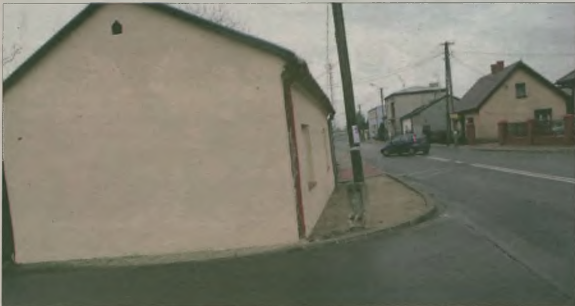
Ten dom przy wyjeździe z ulicy Wschodniej zostanie zburzony.
