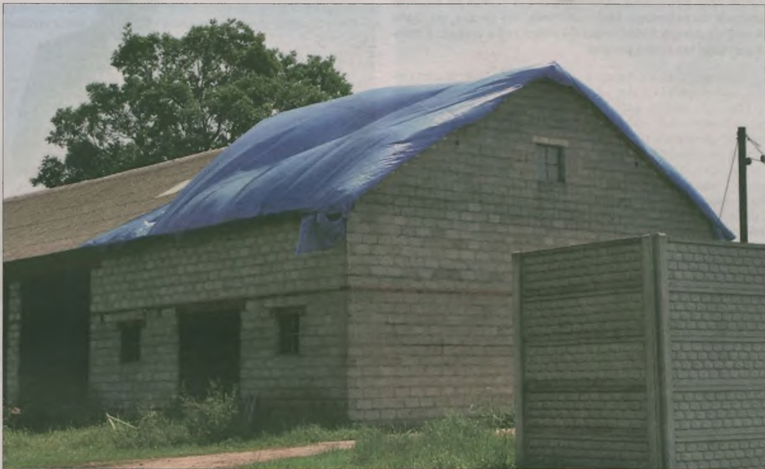
Strażacy ochotnicy z gminy Brudzew kilka godzin zakładali plandekę na dach stodoły w Krwonach.
