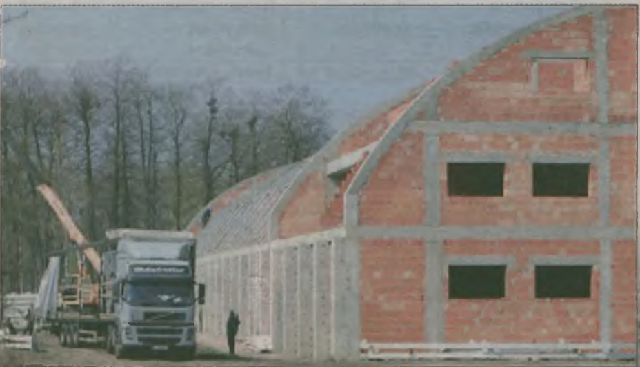
Za moment rozpocznie się kładzenie poszycia dachu.
