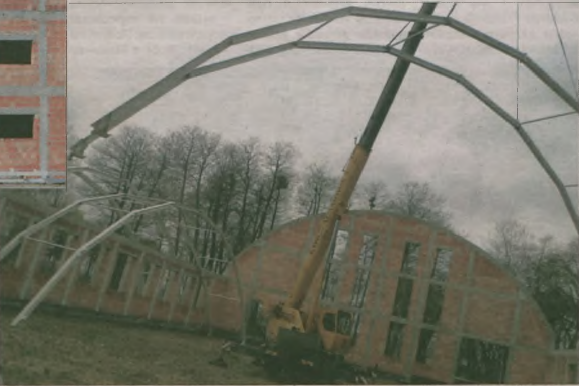
Montaż konstrukcji dachu hali.
