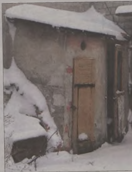
Ubikacja znajduje się kilkanaście metrów od domu.
