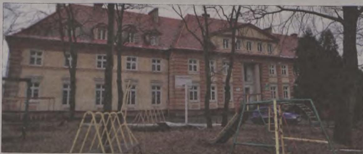
Budynek starostwa przy Konińskiej 1 wraz z otaczającym parkiem został wpisany do rejestru zabytków. Wymiana dachu, renowacja i adaptacja do innych potrzeb niż dom dziecka będzie kosztowała ogromne pieniądze. Wystarczy jednak poczekać kilka, kilkanaście lat i z rejestru może zostać wykreślony ze względu na „fatalny stan techniczny”. Czy i ten obiekt spotka taki los?
