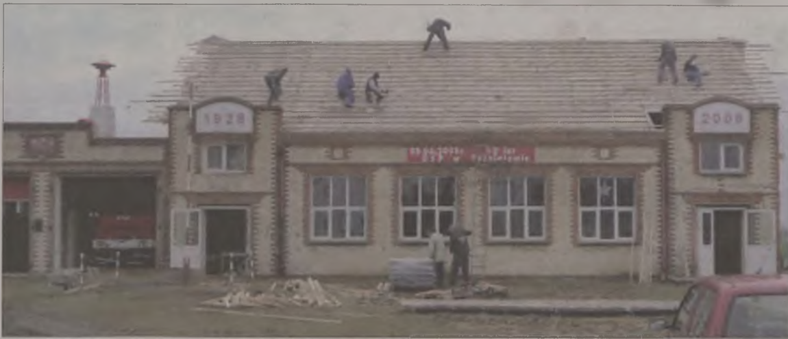
Remiza w trakcie remontu dachu.
