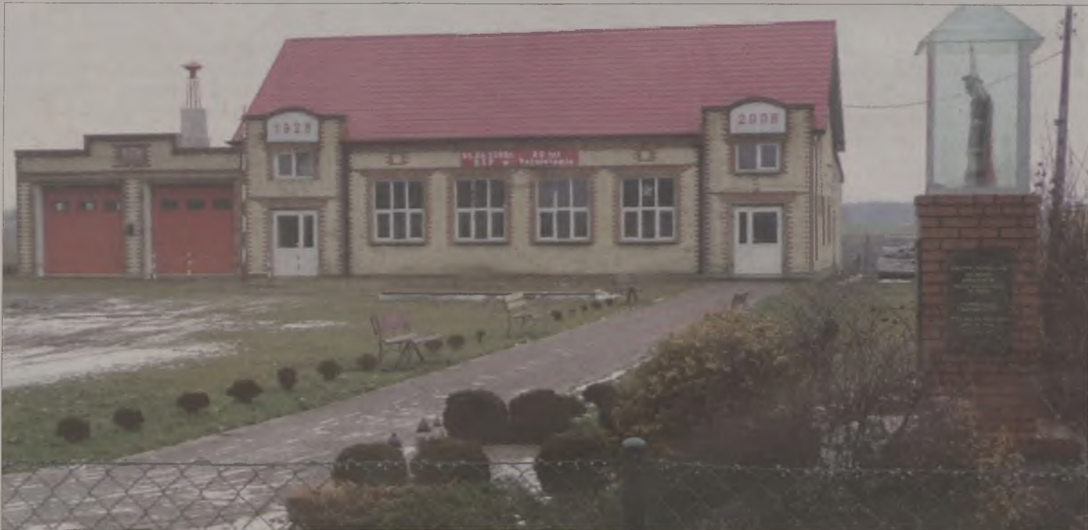
Remiza z nowym dachem i bramami garażowymi.
